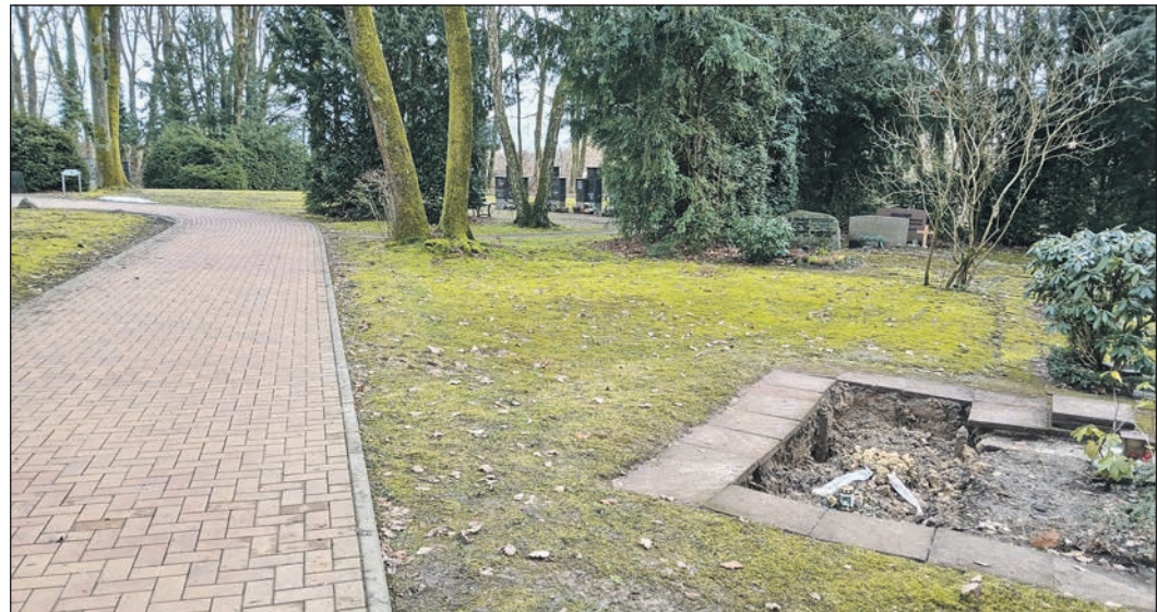
Der Schein trägt: Dieses Grab am Waldfriedhof ist keineswegs offen, sondern nur von einer starken Setzung betroffen. In Kürze soll es verfüllt werden. Foto: Schlosser
