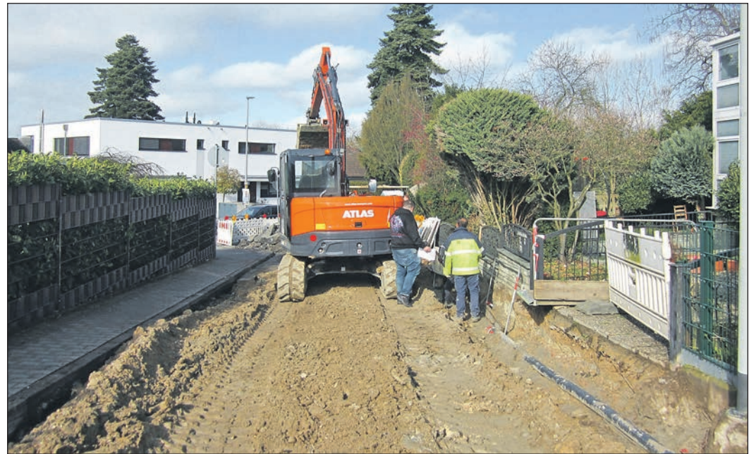
Seit Anfang März rollen im Finkenweg die Bagger. Im ersten Bauabschnitt wurde der alte Straßenbelag bereits abgetragen. Foto: Stadt Schwalbach
