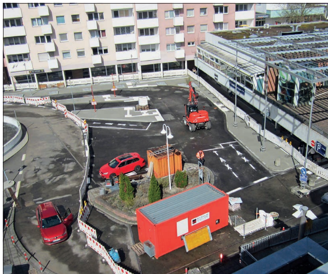
Der Bahnhofsvorplatz wird am Freitag wieder freigegeben.
