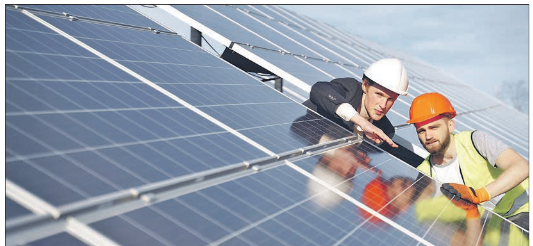
Solaranlagen für saubere Energie.
