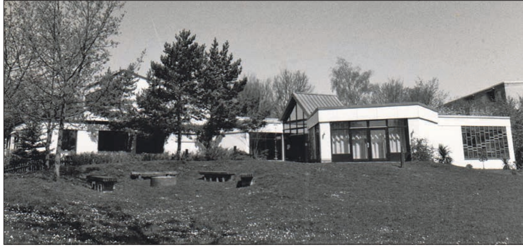
So sah das Gebäude der Evangelischen Limesgemeinde 1970 aus. Die heutige Kita „Mittendrin“ war damals noch nicht gebaut. Archivfoto: Ev. Limesgemeinde
