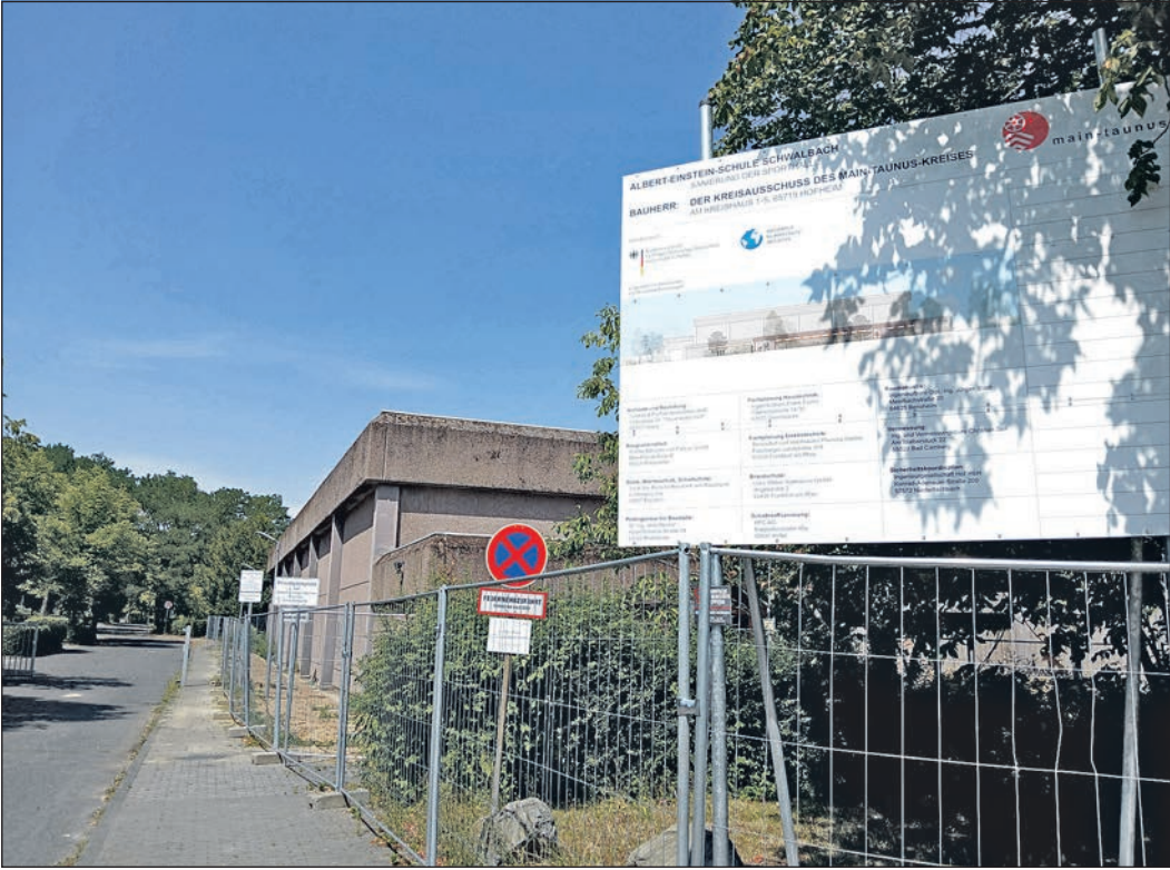
Ein ganzes Jahr lang wird die 45 Jahre alte Turnhalle der Albert-Einstein-Schule saniert. Sportunterricht ist dort im neuen Schuljahr nicht möglich. Foto: Schlosser
