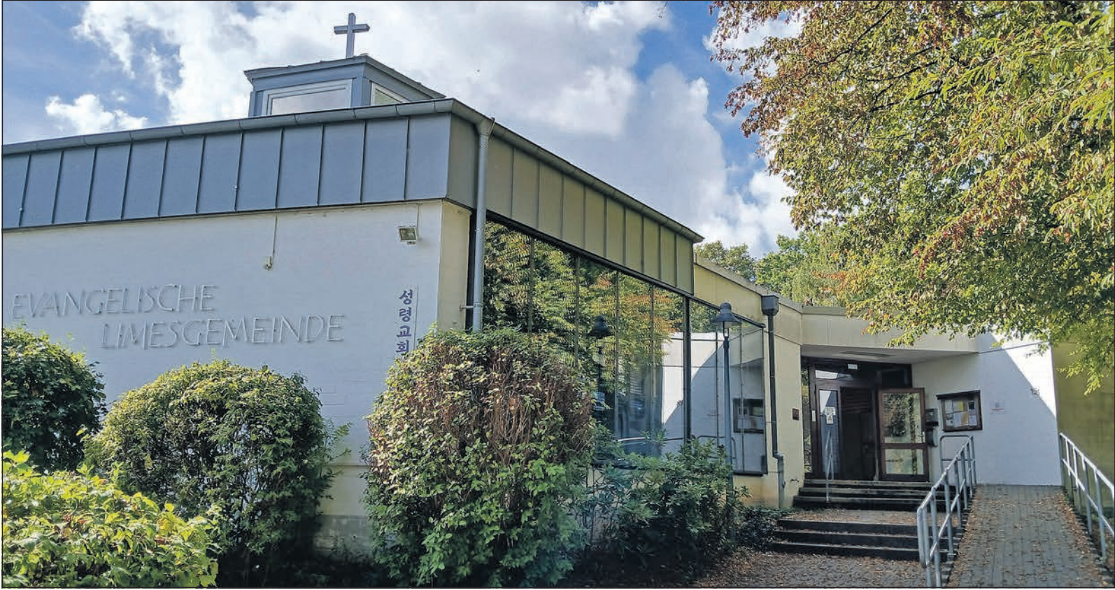
Zu einem radikalen Schritt hat sich die Evangelische Limesgemeinde entschlossen. Schon im kommenden Sommer will sie ihr Gemeindezentrum am Ostring stilllegen. Wie es mit dem Gebäude weitergeht, ist unklar. Für die Gemeinde selbst gibt es aber Perspektiven. Foto: Schlosser
