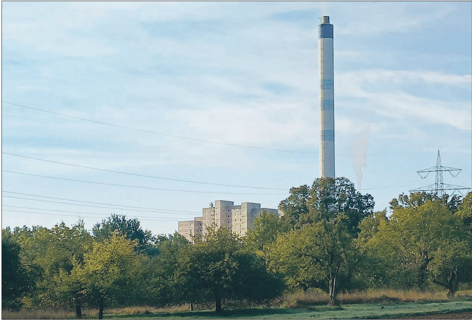
Unablässig rauchen die beiden Kamine des Schwalbacher Heizkraftwerks in der Adolf-Damaschke-Straße, das die gesamte Limesstadt und einige Straßen in Alt-Schwalbach mit Fernwärme versorgt. Die Preise dafür wurden jetzt vom Oberlandesgericht Hamm als „rechtswidrig“ eingestuft. Foto: Schlosser
