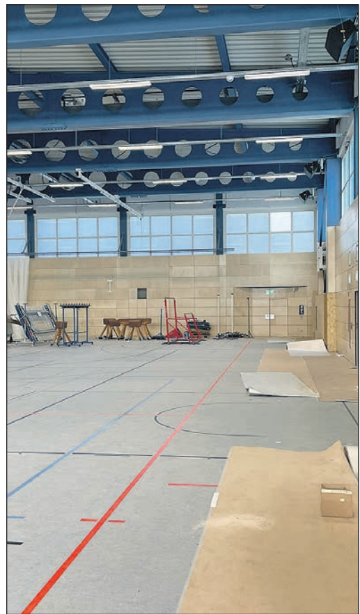
Die umfangreiche Sanierung der Sporthalle der Erich-Kästner-Schule steht kurz vor dem Abschluss.
