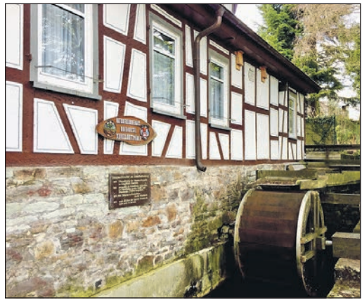
Die Schuckardt mill
