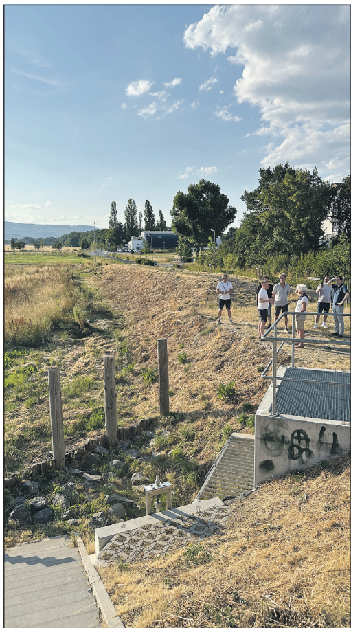
Regenrückhaltebecken in der Waldstraße, Fassungsvermögen 7.000 Kubikmeter Foto: Grüne
