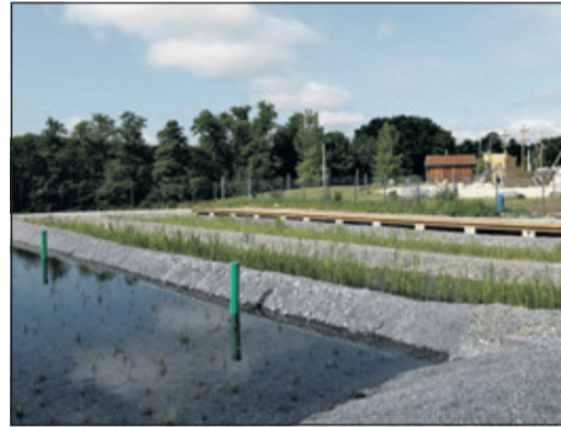
Das Regenerationsbecken wurden aufwändig erneuert. Foto: Stadt Schwalbach
