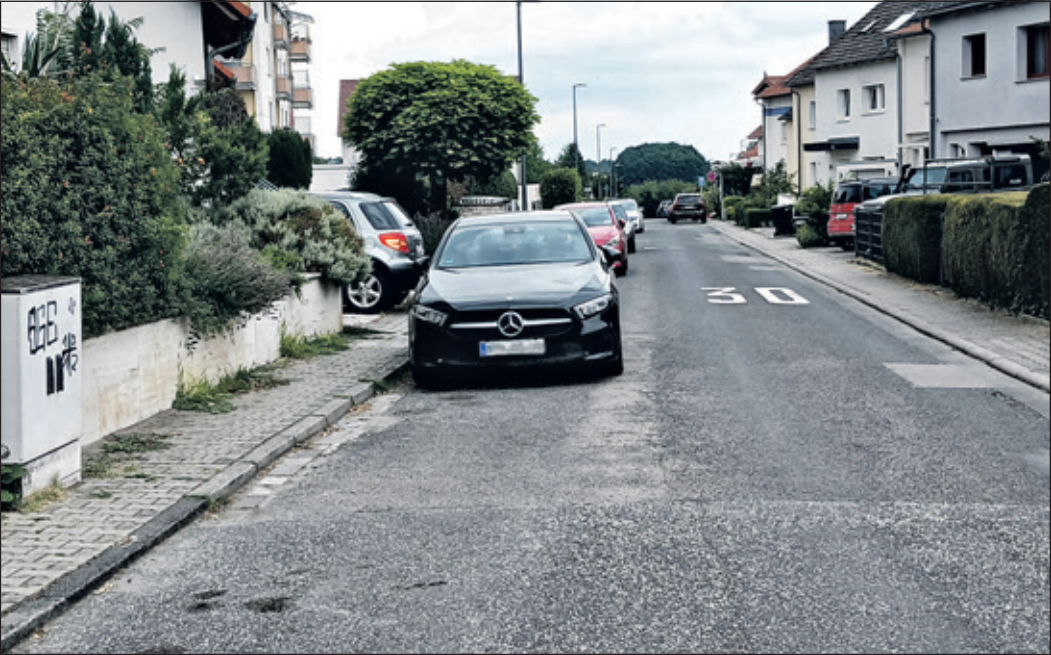
Nach der Sanierung soll der linke Gehweg deutlich breiter werden als sein Gegenüber, damit Kinder und Eltern die Kita „Rübenacker“ gefahrlos erreichen können. Neben der Fahrbahn werden auch Wasser- und Abwasserleitungen erneuert.
