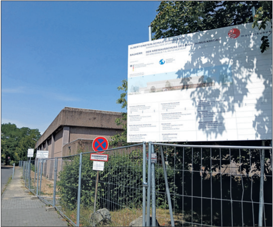
Ein ganzes Jahr lang wird die 45 Jahre alte Turnhalle der Albert-Einstein-Schule saniert. Sportunterricht ist dort im neuen Schuljahr nicht möglich. Foto: Schlosser
