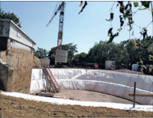
Eine gewaltige Baugrube haben Bagger in den vergangenen Wochen für den neuen Tiefsammelbehälter der Gemeinde am Oberliederbacher Weg ausgegraben. Foto: Schlosser
