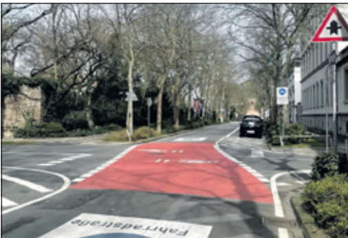
So wie hier in Darmstadt könnten künftig auch die Kreuzungen im Bereich der Neugartenstraße aussehen Foto: R&T
