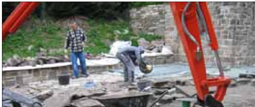
Mensch und Maschine arbeiteten bis zuletzt Hand in Hand, um im fünften und letzten Bauabschnitt den Boden des Ehrenmals wieder sicher begehbar zu machen. Foto: Giese
