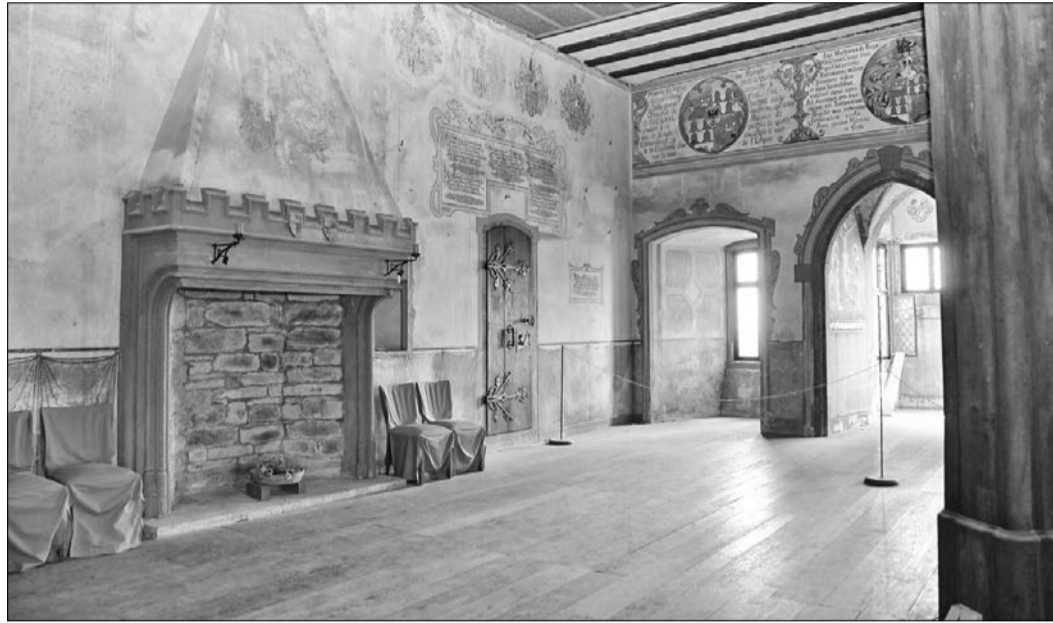
Der Wappensaal im Zustand vor der aktuellen Renovierung.
