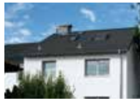
Energetische Sanierung mit Dachsteinen
