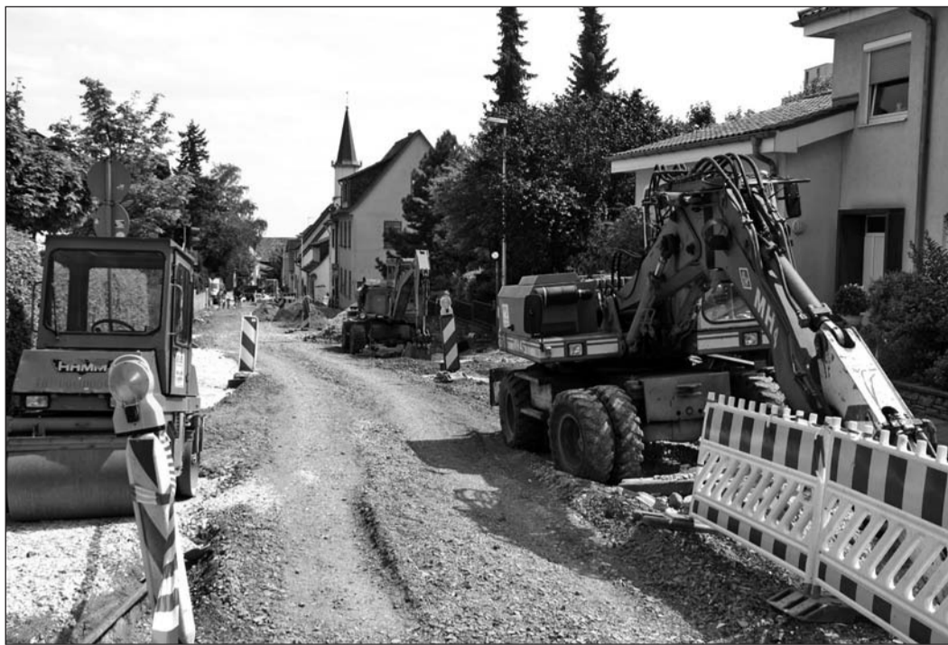
Derzeit wird die Taunusstraße mit Hochdruck saniert. Bis zum 21. August soll sie fertig sein. Foto: ach
