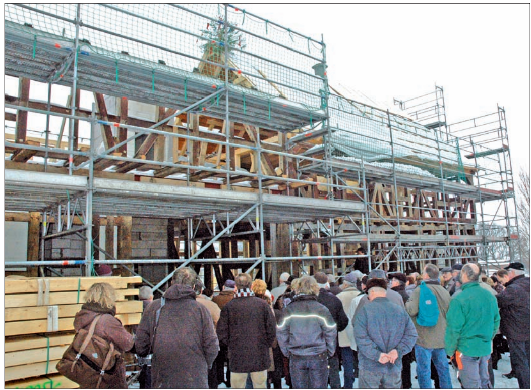
Die Martinsklause aus Remsfeld in Nordhessen erlebte jetzt während des Wiederaufbaus im Freilichtmuseum Hessenpark ihr zweites Richtfest. Foto: rea
