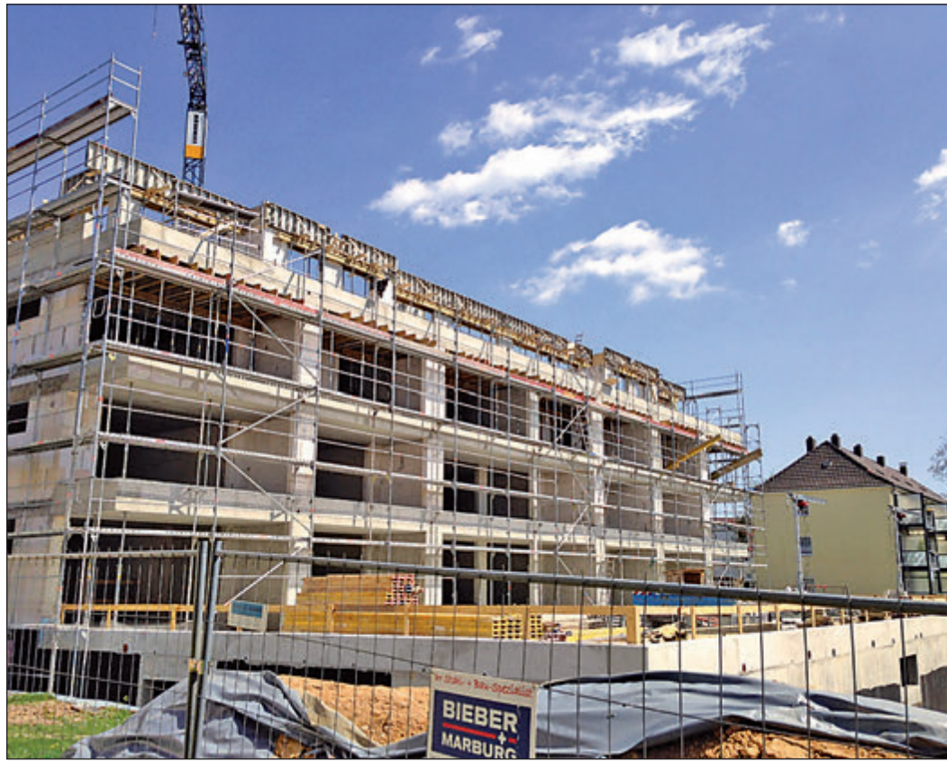
Im Kronberger Carree an der Wiesbadener Straße errichtet die Hochtaunusbau einen Neubau.
