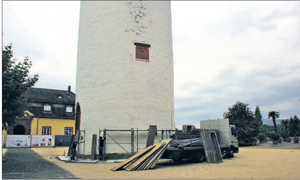
Jetzt wurde damit begonnen, das Gerüst am Weißen Turm zu errichten.
