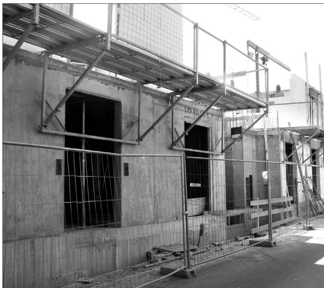
Die Fassaden der Wohnhäuser an der Waisenhausstraße orientieren sich an der traditionellen Bebauung. Fotos: Ludwig
