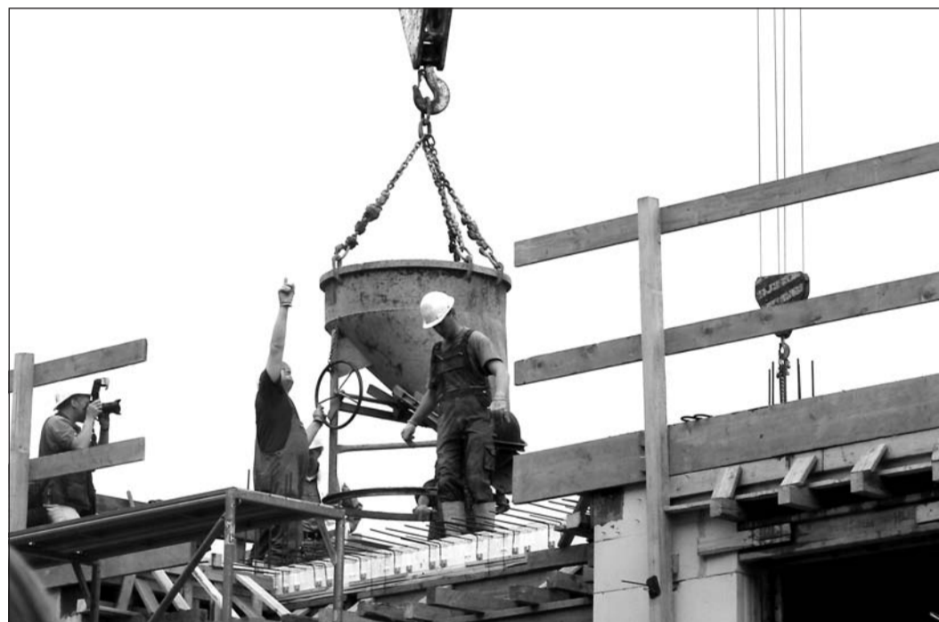
Drei Kräne stellen auf der Großbaustelle der „Dorotheenhöfe“ den Nachschub für die Bauarbeiter sicher.
