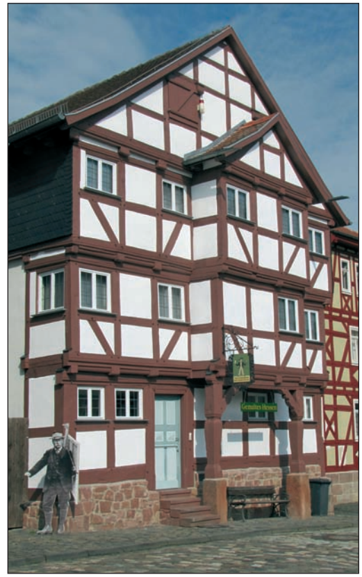
Nach einjähriger Sanierungs- und Umbauzeit ist das „Gemäldehaus“ auf dem Marktplatz des Freilichtmuseums Hessenpark wieder für die Museumsbesucher zugänglich.
