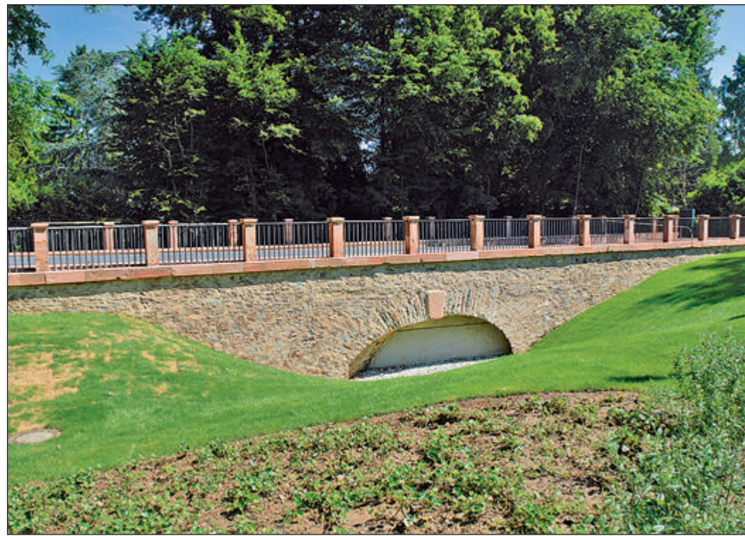
Die Carolinenbrücke in Bad Homburg ist heute wieder ein Schmuckstück, nachdem sie jahrzehntelang zugeschüttet und nicht mehr als Bauwerk zu erkennen war.
