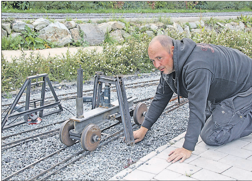
Ralph Müller zieht die Schienen am Ende des Bahnhofs hoch, um eine Welle zu entfernen.
