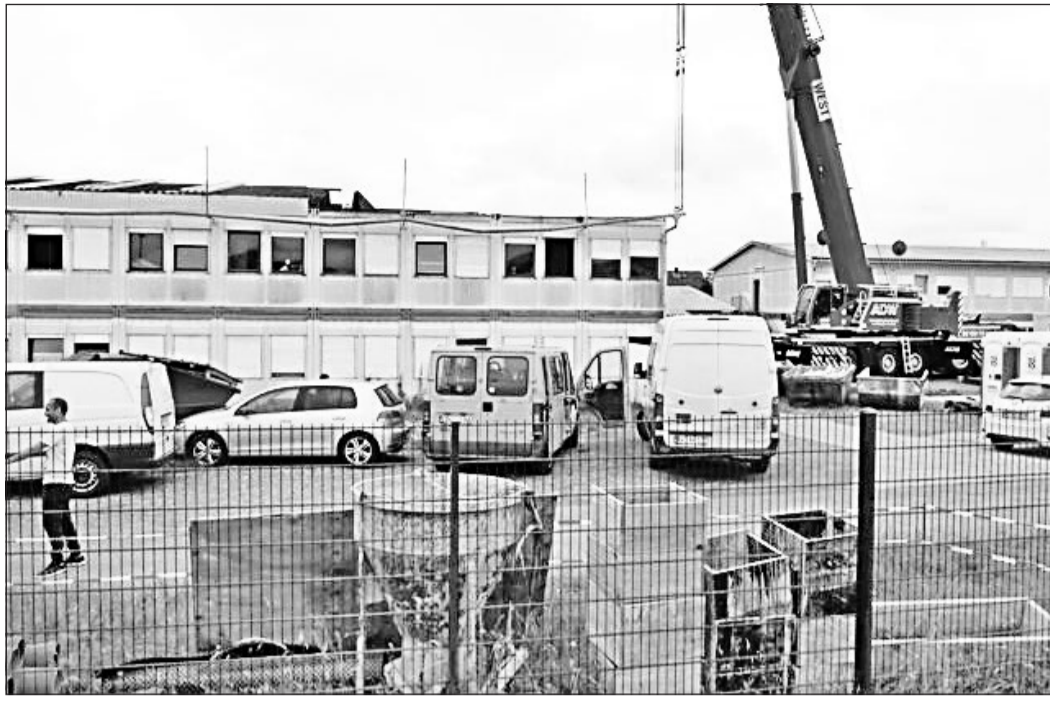
Der Abriss der maroden Flüchtlingsunterkunft hat begonnen.
