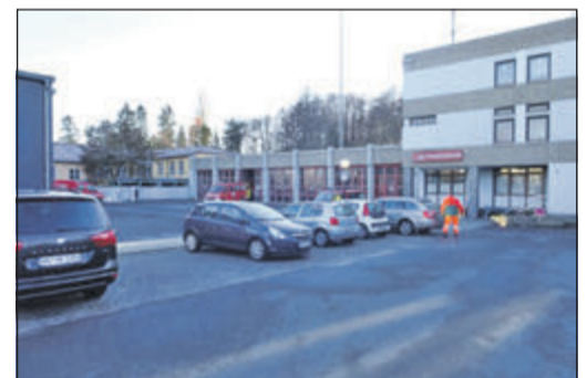
Der Feuerwehrstützpunkt Marxstraße weist eine Reihe von Mängeln auf. Foto: HB
