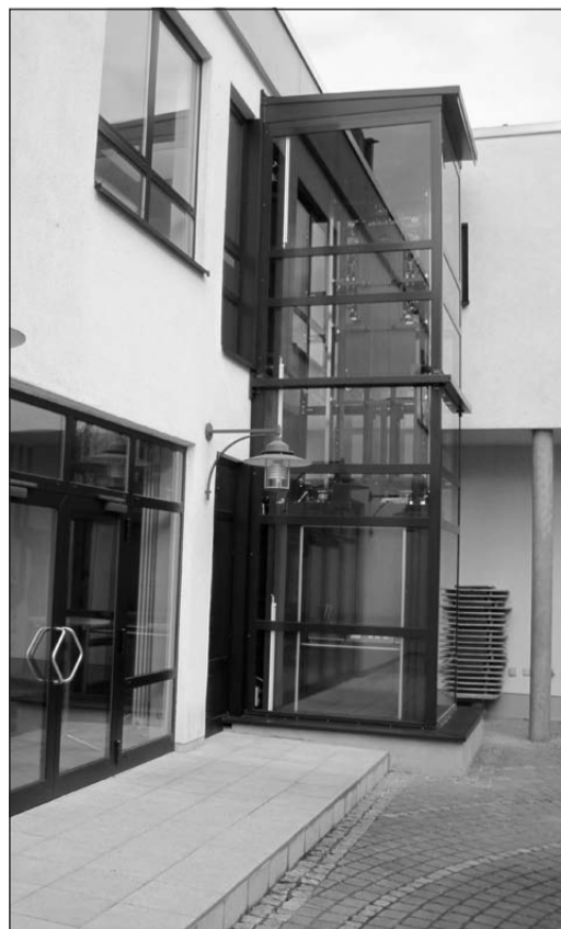
Ein gläserner Lift im Gemeindezentrum sorgt für barrierefreien Zugang.
