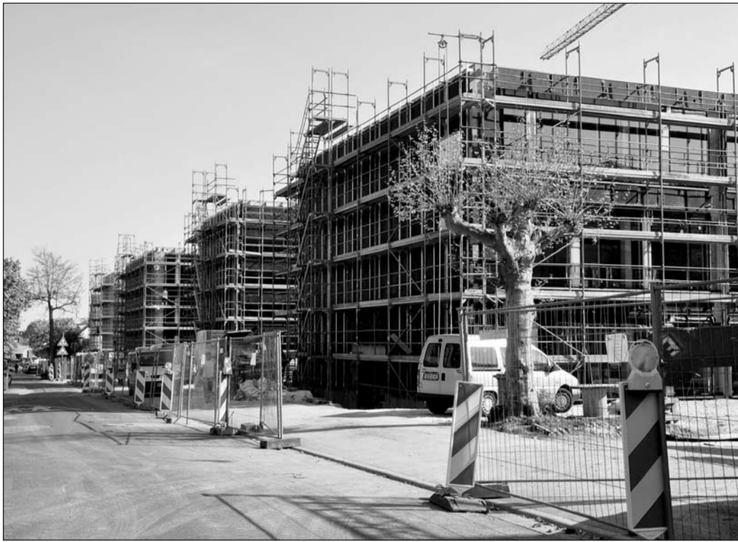
Die Bauarbeiten am Gymnasium gehen voran, im Herbst sollen die ersten Klassen bereits einziehen können. Foto: Klein
