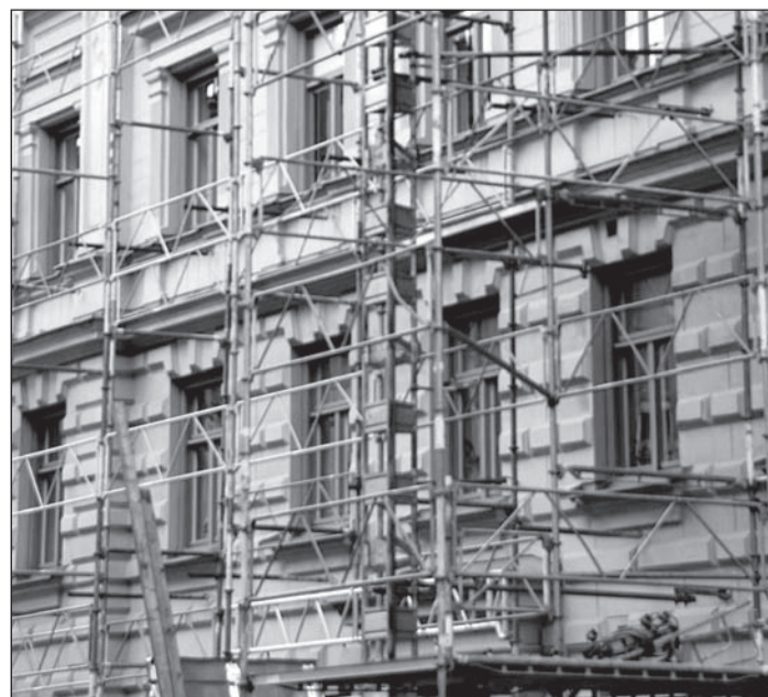
Ips/Du. Bei höheren Häusern empfiehlt sich die Aufstellung eines Gerüsts für die Fassadensanierung. Foto: Puvo!
