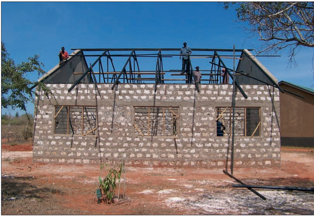
Der Schreinerlehrer mit Lehrlingen baut den Dachstuhl.
