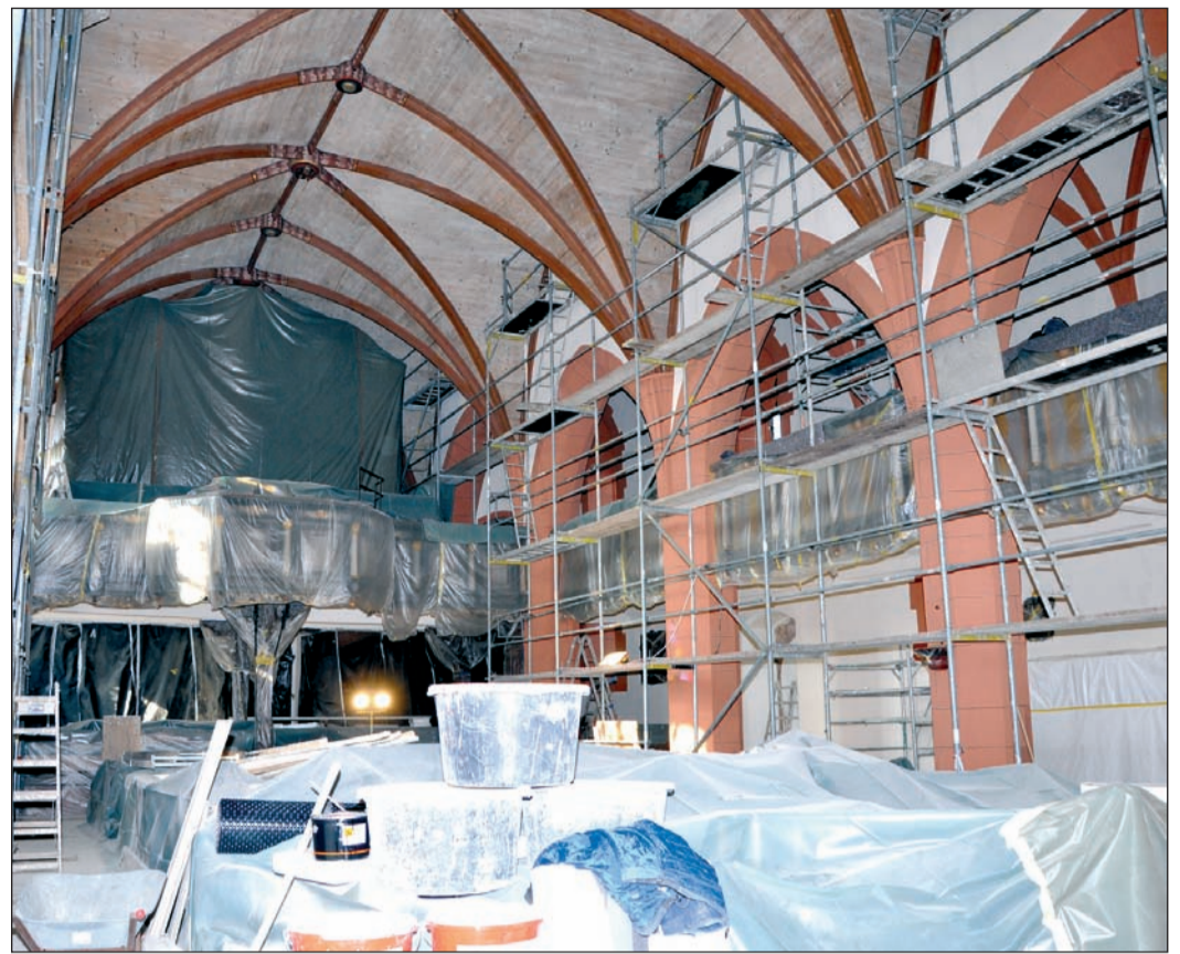
Die Elektro- und Unterputzarbeiten sind soweit durchgeführt, derzeit sind die Malerarbeiten in der Kirche St. Ursula in vollem Gange. Foto: Klein
