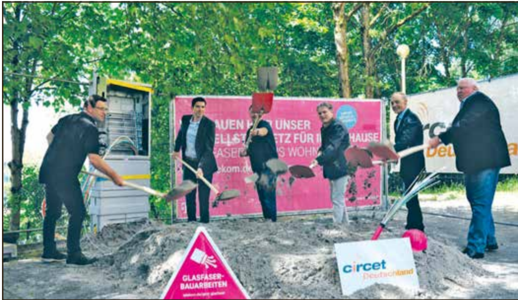
Der Glasfaserausbau startet in allen Bauabschnitten.
