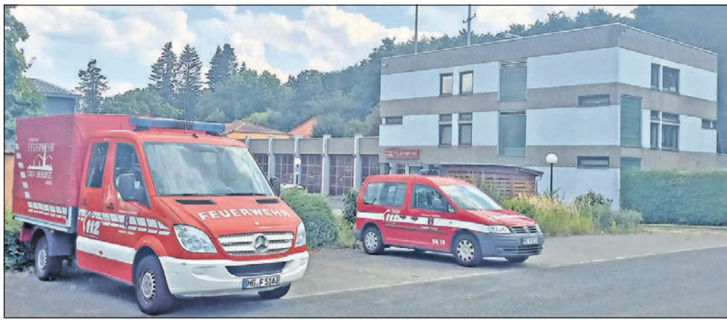
Zu alt, zu klein, zu schlecht ausgerüstet: Das 50 Jahre alte Feuerwehrhaus an der Marxstraße hat ausgedient, es wird höchste Zeit für eine Modernisierung der Wehr am neuen Ort angesichts der vielen neuen Aufgaben. Foto: js
