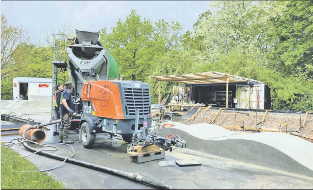
Mit Hochdruck wird an der neuen Skateanlage an der Saalburgstraße gearbeitet, damit sie schon bald genutzt werden kann. Foto: Stadt
