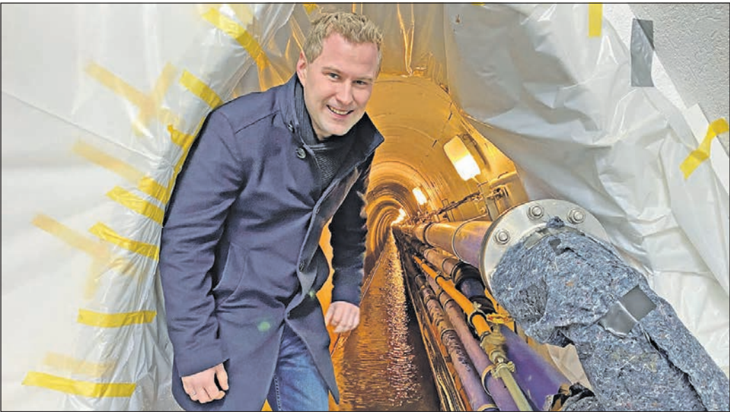
Bürgermeister Dr. Oliver Jedynek wagt einen Blick in den Stollengang. Foto: Stadt
