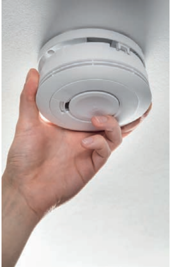
Vor dem Renovieren sollten Rauchmelder von der Montageplatte abgedreht werden, um sie vor Staub und Farbe zu schützen. (Foto: epr/Ei Electronics)
