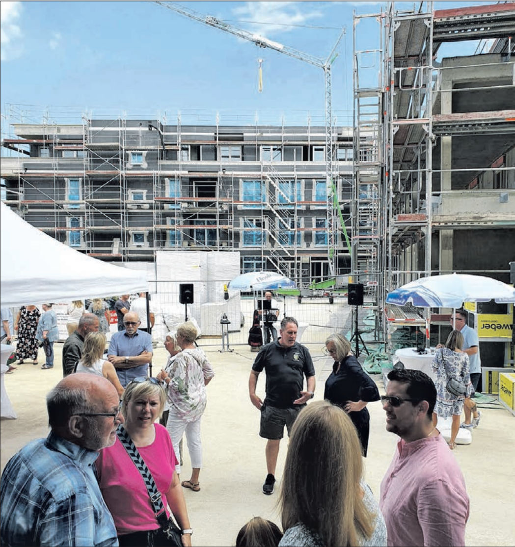
Baustelle und Sommerfest – so sah es aus, als sich in der neuen Residenz neue Bewohner und Bauleute trafen, um Informationen über die neue weitläufige Anlage zu erhalten.
