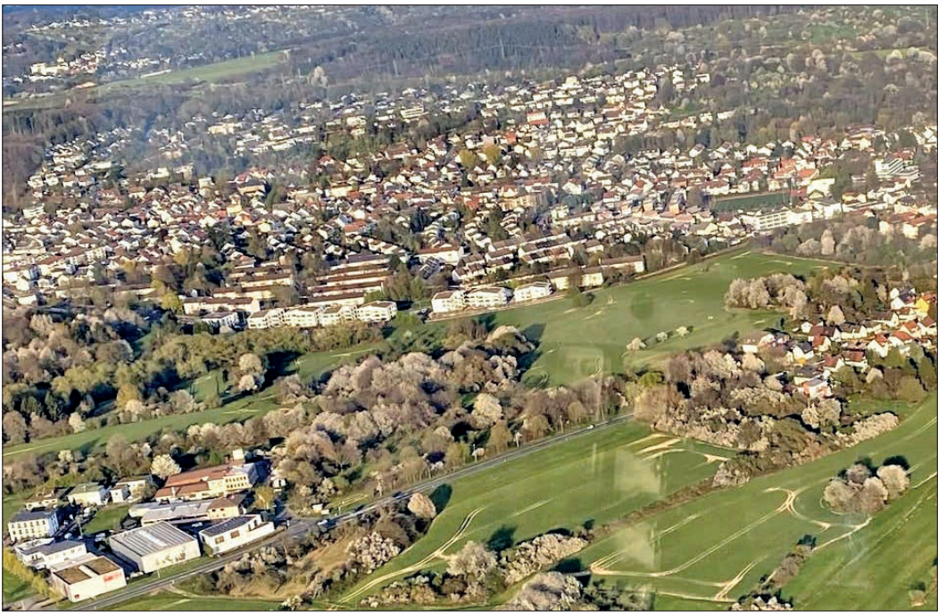
Der Blick von oben auf das Areal. Zwischen den Neubauten am Gagernring (Bildmitte) würde die Gagernspange beginnen und am Hühnerberg (unten links) enden. Felder und Bäume müssten dem Feuerwehr-, Straßen- und Wohnungsbau weichen.
