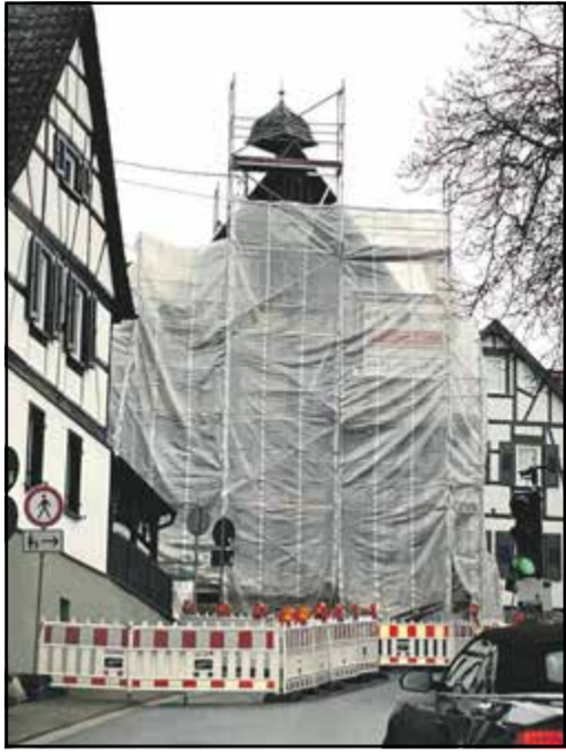
Zumindest diese Baustelle sollte bald beendet sein. Foto: Scholl
