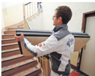
Handlich im Format, praktisch in der Verarbeitung: Die Rigidur Dachbodenelemente 032 TF (500 x 1.500 mm) bestehen aus einer hoch wärmedämmenden, graphit-veredelten EPS-Dämmung und einer robusten Oberlage aus Gipsfaserplatten. (Foto: epr/Saint-Gobain Rigips)
