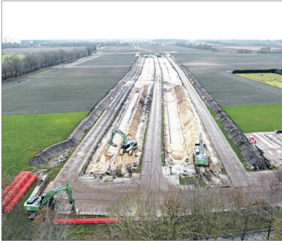
Nachher soll hier wieder Gras und Getreide wachsen - doch während der Bauarbeiten und dem Verlegen der Kabel sieht eine solche Erdkabeltrasse schon zum Fürchten aus. Das Bild zeigt die Trasse A-Nord im Bereich des Emslands. **Foto: Amprion**
