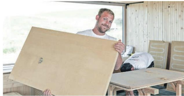
Den Einbau einer energiesparenden und wohnbehaglichen Deckenheizung mit Lehmputz-Trockenbauplatten können versierte Heimwerker selbst in die Hand nehmen. Foto: DJD/Naturbo
