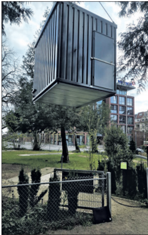
Am Mittwoch schwebte das 1,6 Tonnen schwere neue Kassenhäuschen auf dem Minigolfgelände ein. Foto: Stadt Bad Soden
