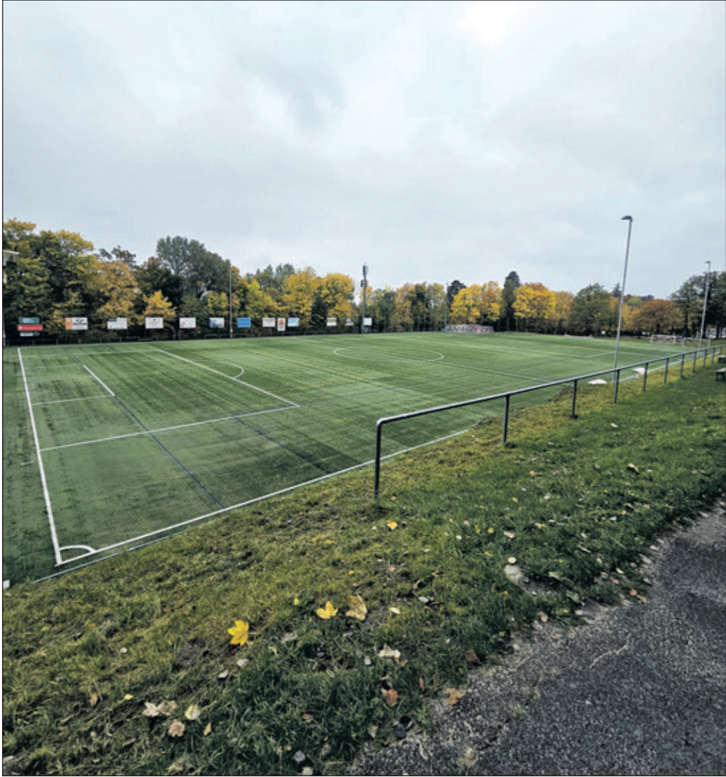
In der zweiten Woche der Herbstferien wurde der Kunstrasenplatz am Waldschwimmbad überarbeitet. Das geschädigte Gummi-Granulat wurde abgetragen und durch Sand ersetzt.
